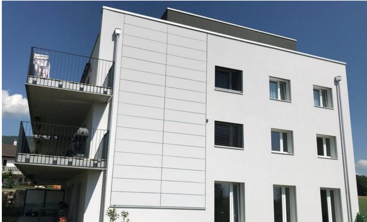
Immeuble à Boudry (NE) de Solaxess
