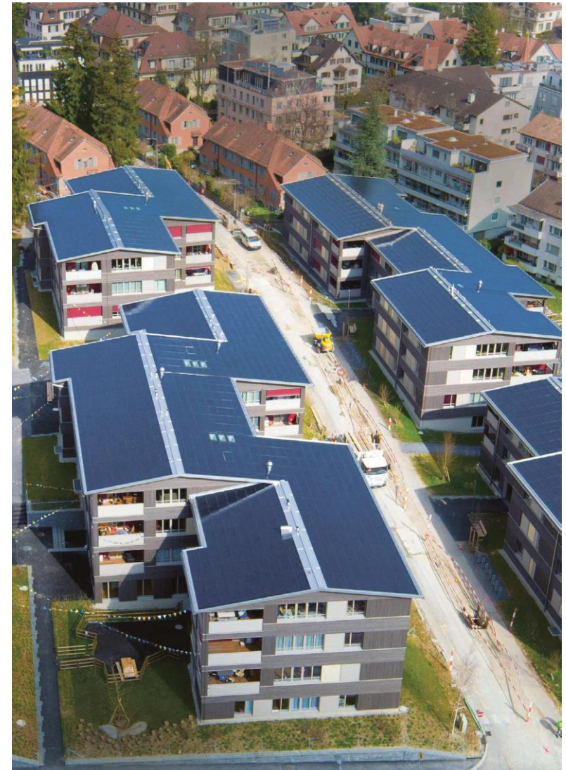
Lotissement de la Balberstrasse © Suntechnics Fabrisolar AG
